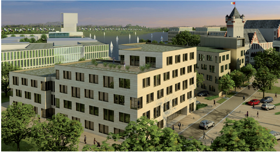
Das HAFENTOR orientiert sich mit seiner prägnanten Fassadenstruktur mit Fenstern und Naturstein am rechts daneben stehenden Gebäude, dem Firmensitz FREUNDLIEB am See. Foto: Planungsgruppe Drahtler
